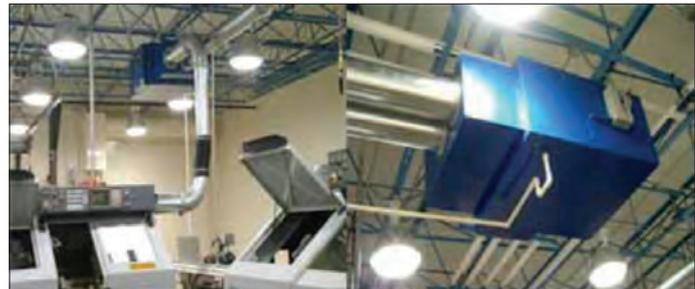
Elektrofilter funktionieren in der nachfolgend geschilderten Weise: Schmutzige Luft wird in das System gezogen und passiert dort zunächst einen Vorfilter, der grobe Verunreinigungen und Flusen abscheidet. Die Luft mit den restlichen Partikeln passiert dann ein elektrostatisches Hochspannungsfeld, wo diese Partikel aufgeladen werden.
